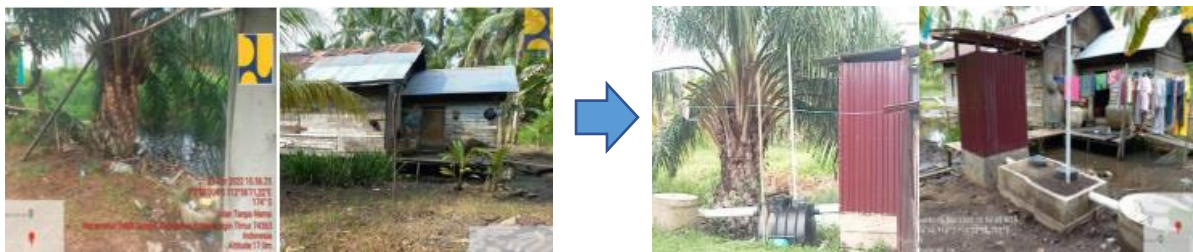
Gambar 3. 19 Pembangunan Sanitasi Sebelum (kiri) dan Sesudah (kanan)
